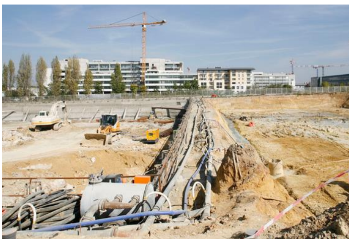
FIGURE 9 - OPÉRATION MASSY ATLANTIS (SOURCE : MTES)
