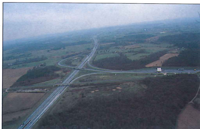
Autoroute A11 - Echangeur de LE MANS - Est
