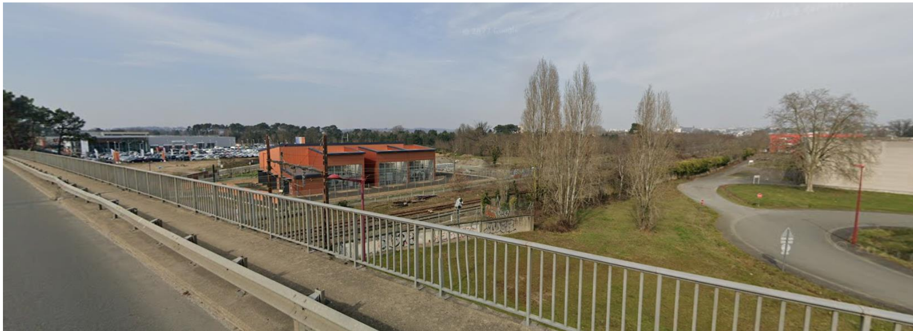
ZAC de la Cartoucherie – Vues lointaines depuis le pont de la rocade (Bd Estienne d’Orves) au-dessus de la voie ferrée (mars 2023)
