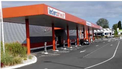
Leclerc Drive au Mans, exemple de drive accolé
