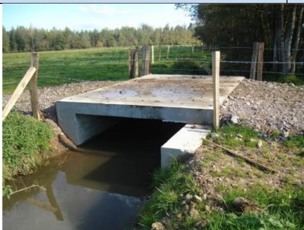
**Figure 19.** Pose d'un dalot en remplacement d'un passage busé mal calé
