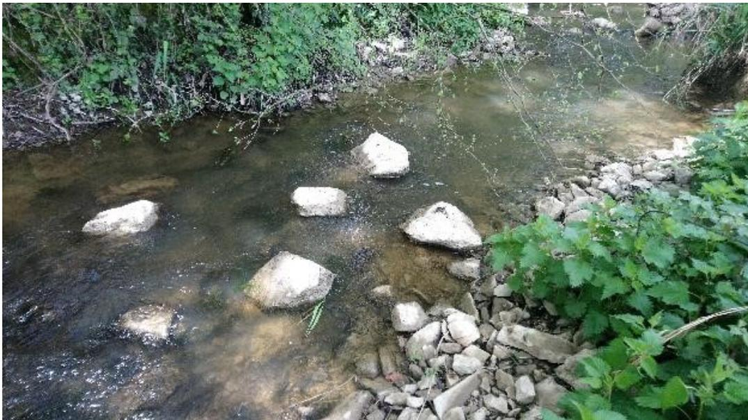
**Figure 16.** Granulat et blocs, diversification des écoulements (source SMVDFG)
