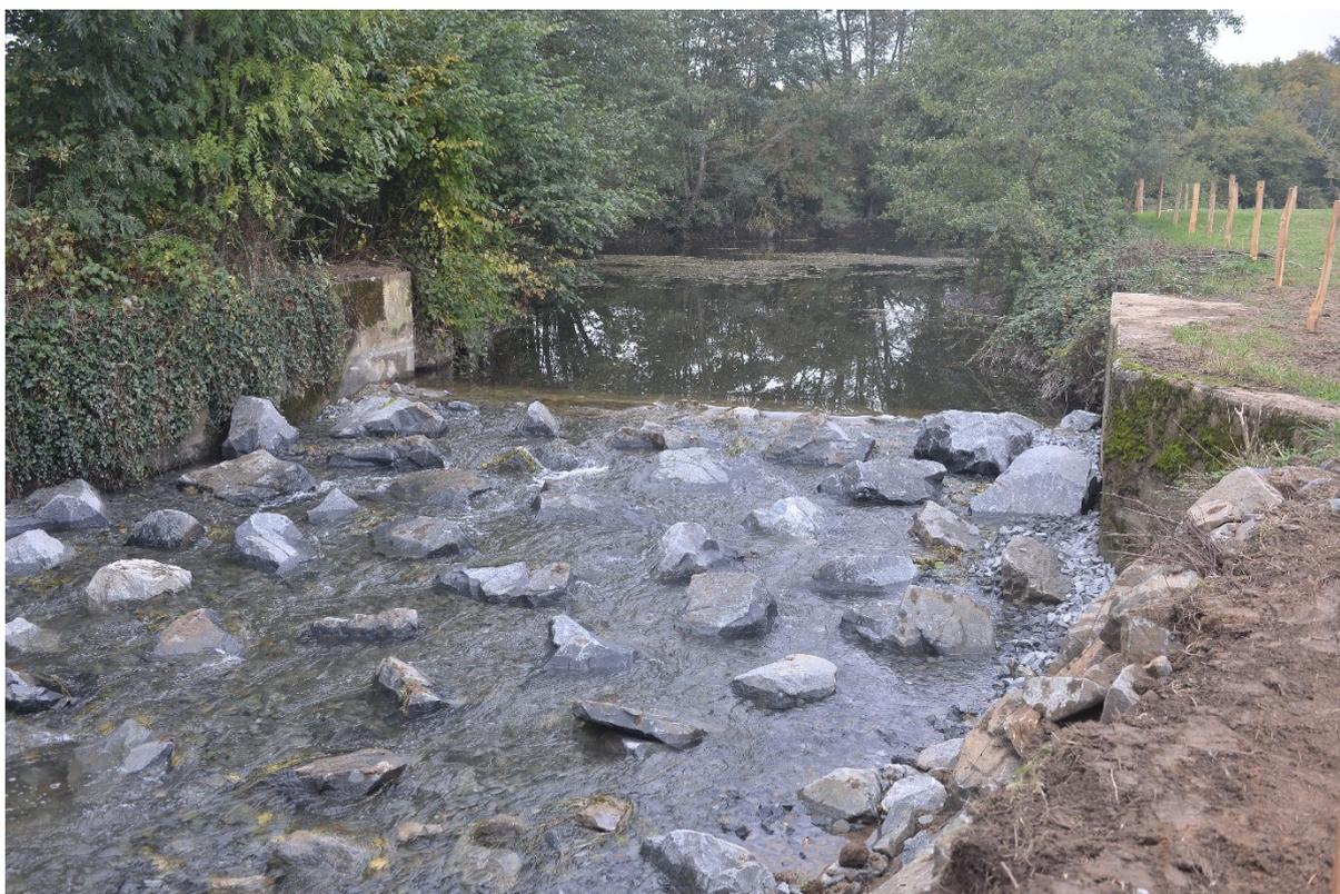
**Figure 26.** *Résultat projet de restauration de la continuité écologique (rampe avec blocs) après effacement du clapet*
