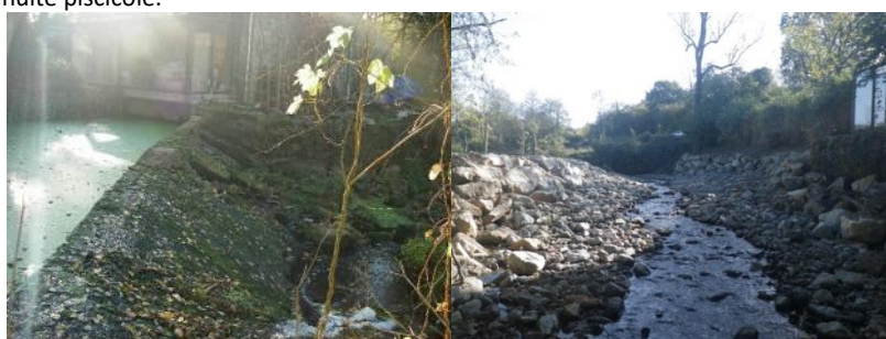
Exemple de seuil arasé sur l'Orgère (85) en avant/après
