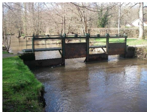
Figure : ouvrage manœuvrable sur le Beuvron
