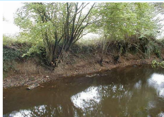
Figure : Exemple de travaux d'élagage
