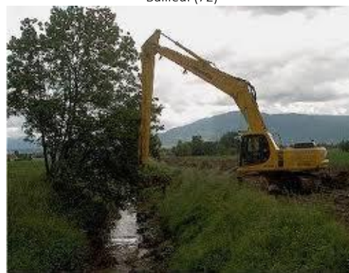
Pelle flottante utilisée lors de travaux sur Grand Lieu (44)
