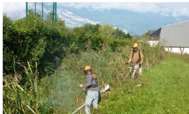
Figure : Chantier de débroussaillage sélectif
