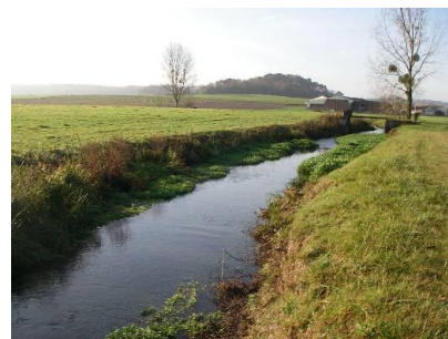
Ouvrage démantelé sur le Couasnon (49) : un nouveau lit se dessine
