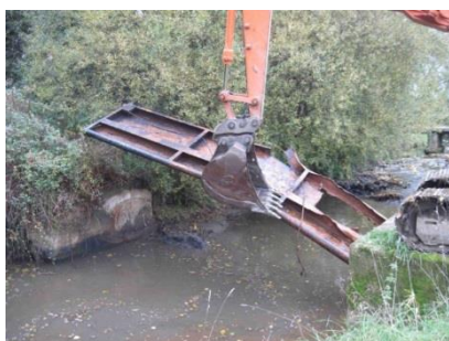
Démantèlement de clapet (Ille et Vilaine)
