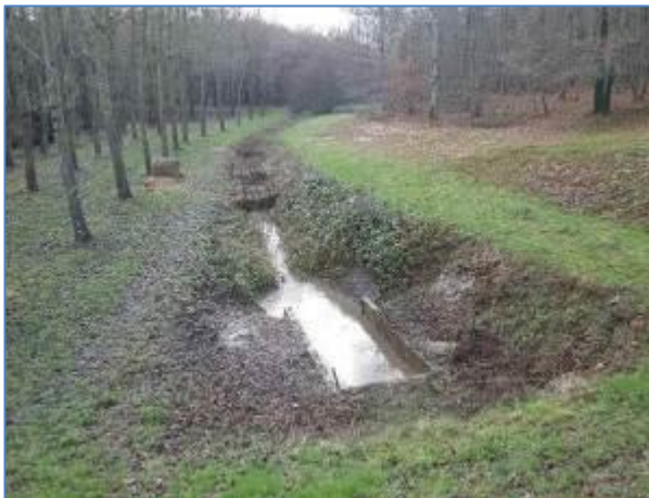
Figure 23 : Exemple de mise en place de bottes de paille dans le lit de la rivière le Long (37), à l'aval d'un étang lors de sa vidange
